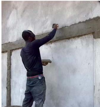
Jetzt schnell den Putz aufziehen, denn durch die Hitze trocknet der teilweise schon auf der Kelle ein, während dem Auftragen. Alles nicht so einfach, vergleichbar mit unseren Temperaturen!
